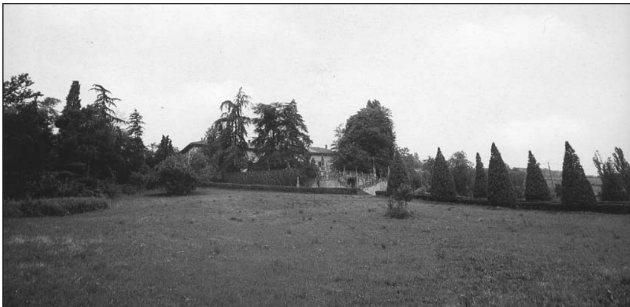
Panoramica della villa circondata dal Giardino
