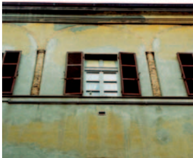
Il fronte sul cortile con le colonne in laterizio
