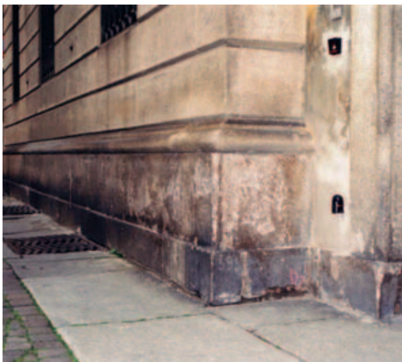
Stato di conservazione del paramento murario prima del restauro
