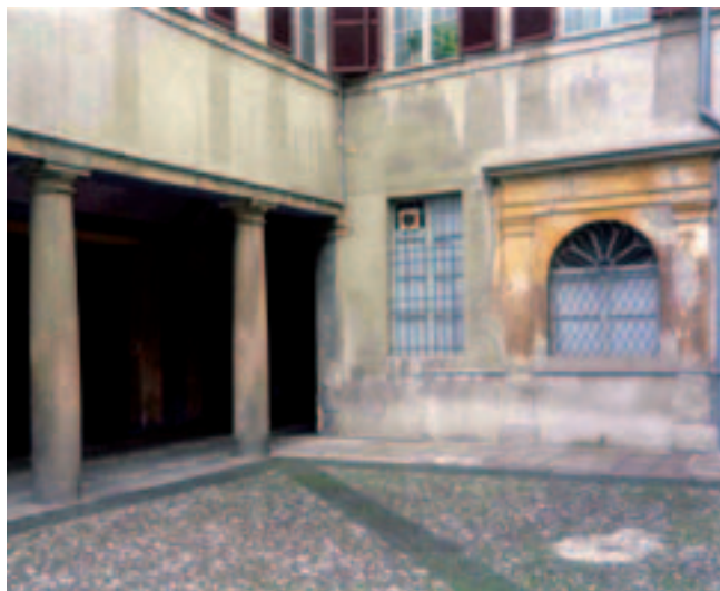
Le colonne neodoriche del portico in granito rosa di Baveno
