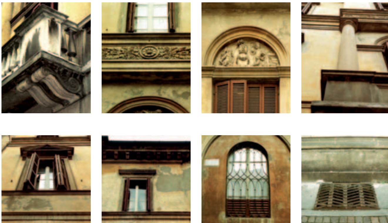
Particolari della facciata prima del restauro
