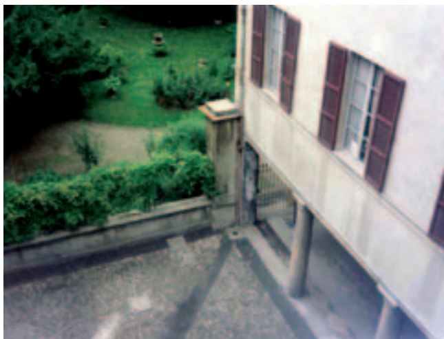
Particolare del cortile d'onore e del giardino
