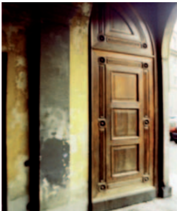
Dettaglio del portone di ingresso a due ante
